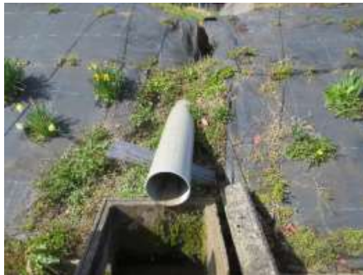
前田茂さん家の横の用水が崩壊している。U字溝12メートル、パイプ4m。
