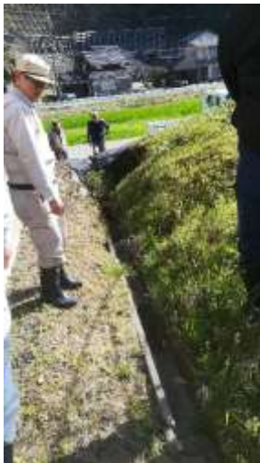
前田茂さん家の横の用水が崩壊している。U字溝12メートル、パイプ4m。
